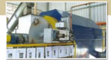
■ 2011年よりスラッジカーボナイザー（汚泥炭化装置）を稼働させ、排水処理装置からの汚泥ゴミを60%減量し、廃棄物を削減
