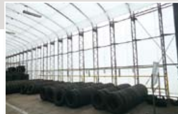
■ 白色のテントに張り替えることで、昼間は蛍光灯が不要になり節電を実現（小野工場）
